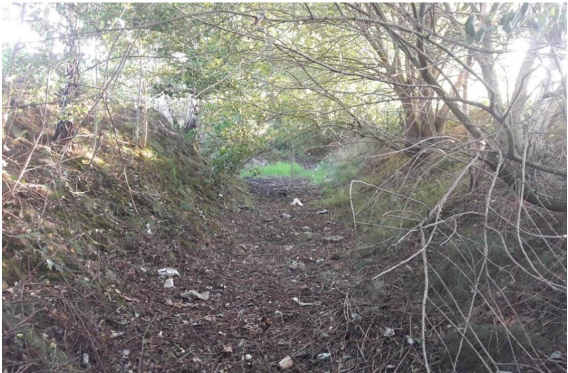
Abb. 20: Blick innerhalb des Regenrückhaltebeckens aus etwa dem Zentrum in Westrichtung (aufgenommen am 04.07.2018).
