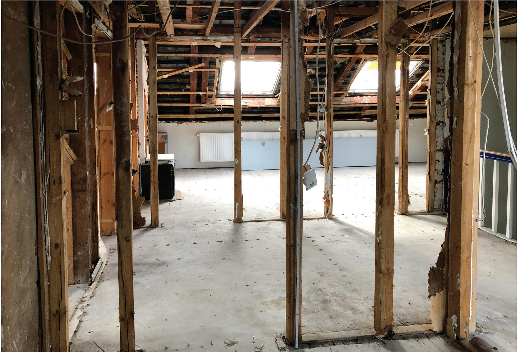
Altbau-Neu Dachstuhl | Bestand nach Rückbau der Trennwände und Öffnung der Dachverkleidung, Stand: März 2020
