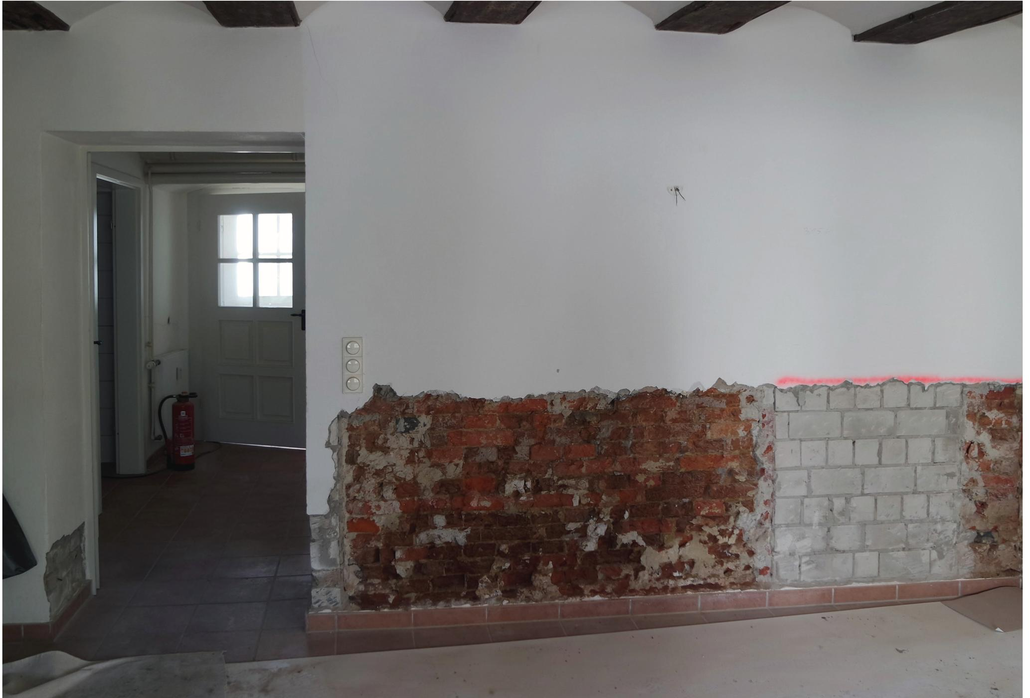
Altbau-Alt Erdgeschoss Gasträume | Öffnung der Wände im Sockelbereich, Abstimmung mit der Denkmalpflege über Umgang mit Feuchtigkeit
