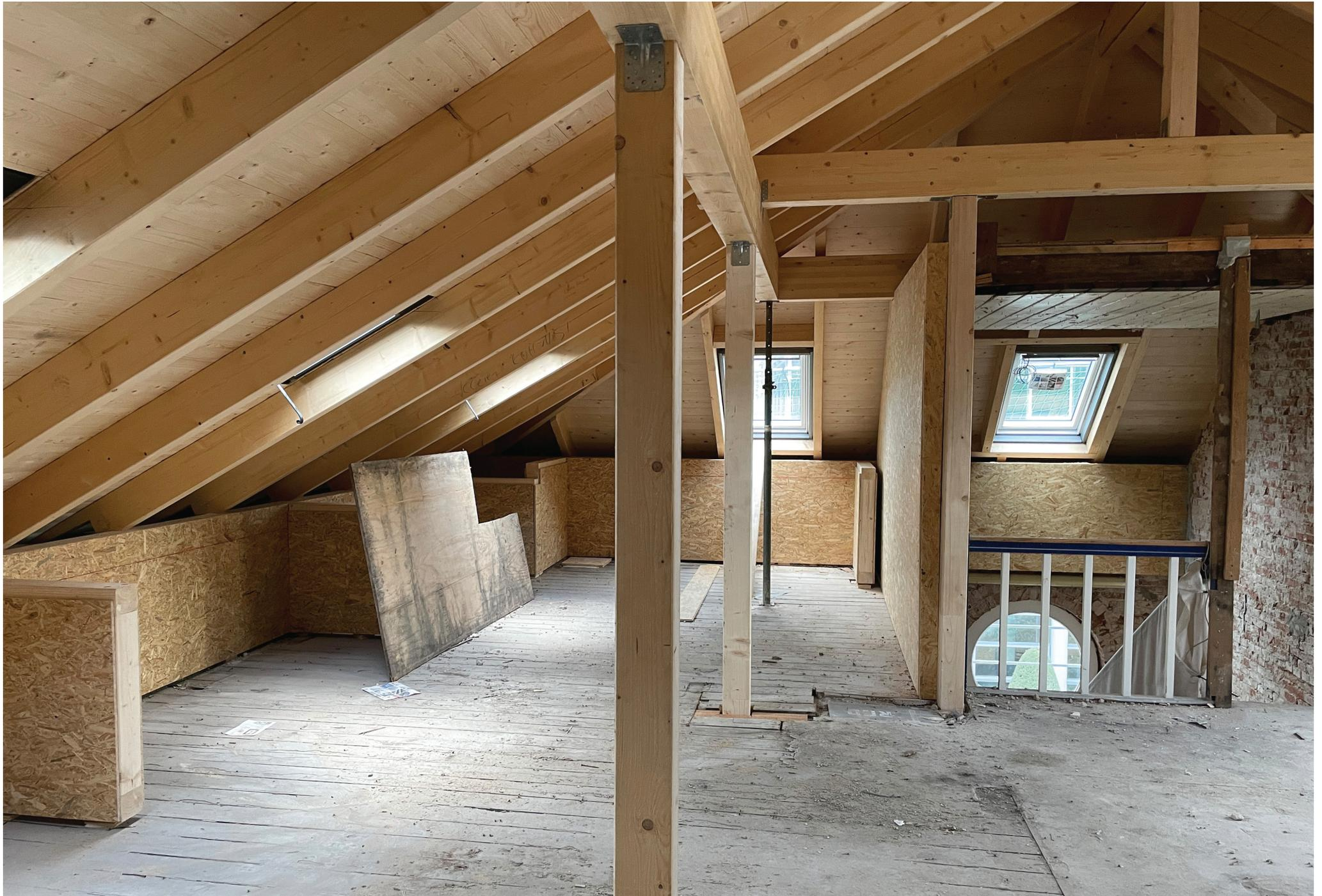
Altbau-Neu Dachstuhl | Abbruch und Neuaufbau im Zuge der Schadstoffsanierung ähnlich der historischen Kubatur und Erhalt des Bestandsdempels
