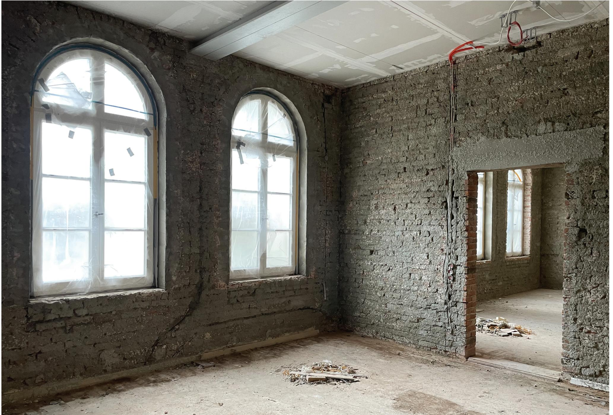
Altbau-Neu Obergeschoss Raum N 1.15 | Stand nach abgeschlossener Schadstoffsanierung (Entfernung Putz, Holzeinbauteile, Bodenbelag, etc.)
