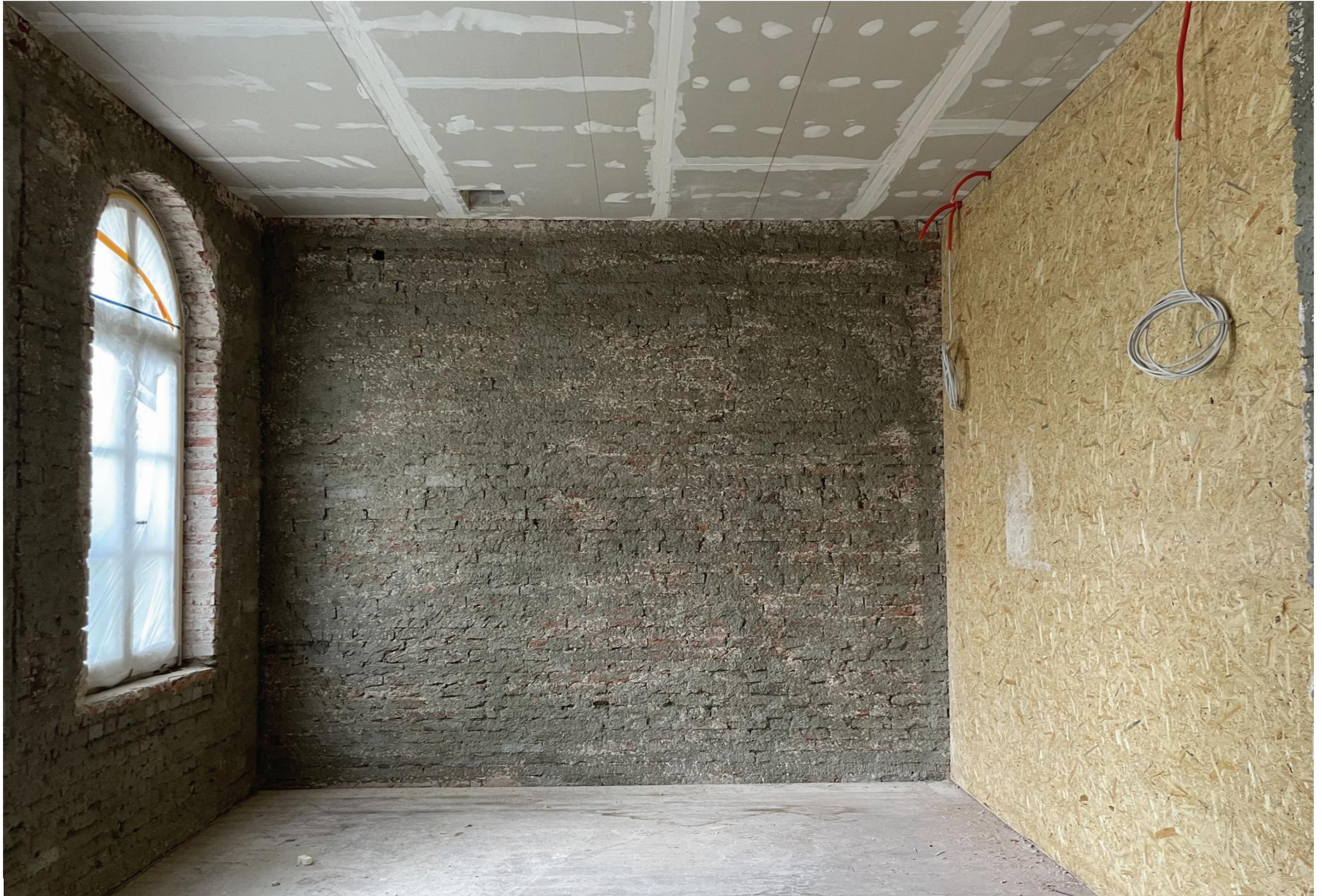
Altbau-Neu Obergeschoss N 1.16 | Exemplarisch für die notwendigen statischen und brandschutztechnischen Ertüchtigungen der Wände und Decken
