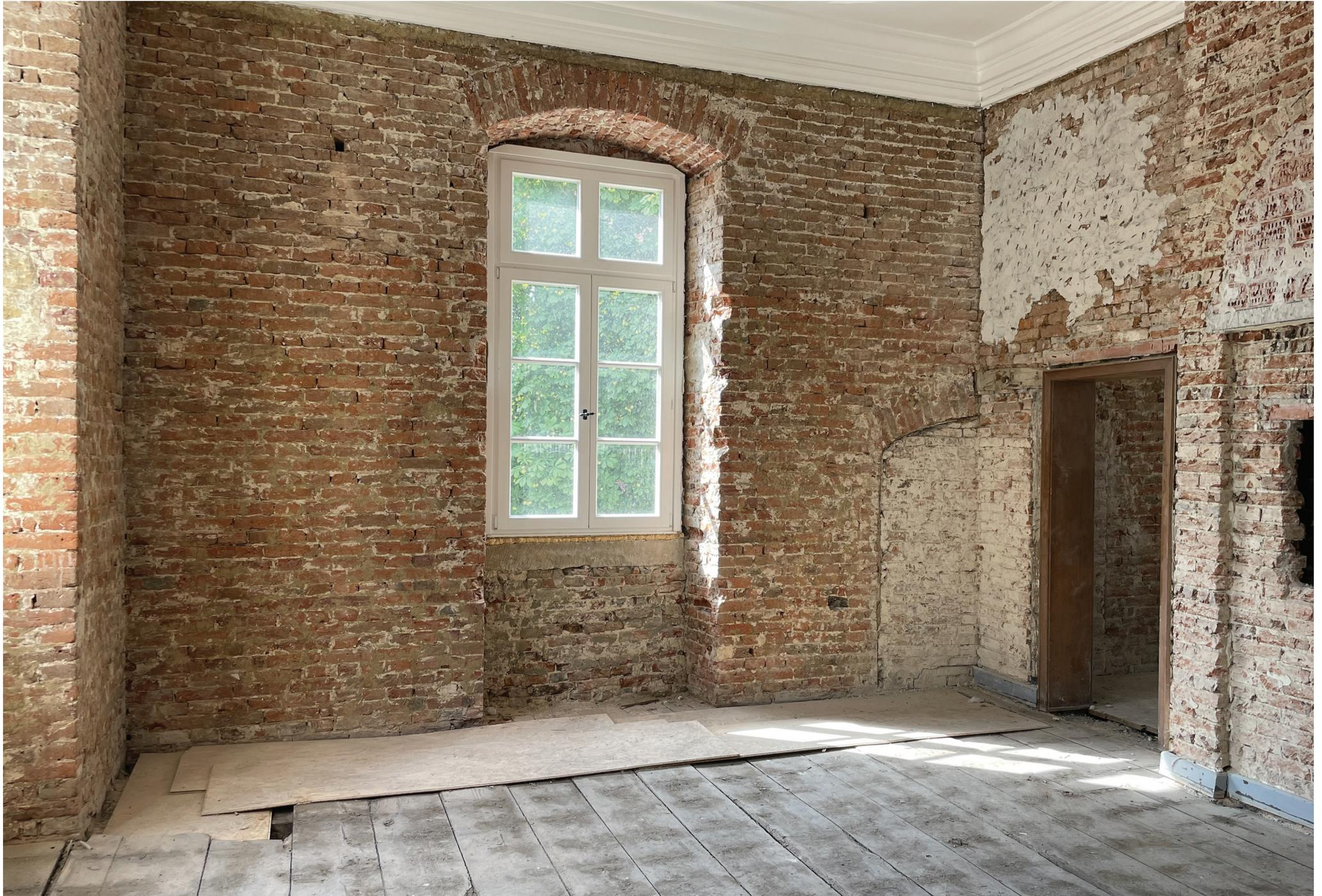
Altbau-Alt Obergeschoss R 1.02 | Stand nach abgeschlossener Schadstoffsanierung
