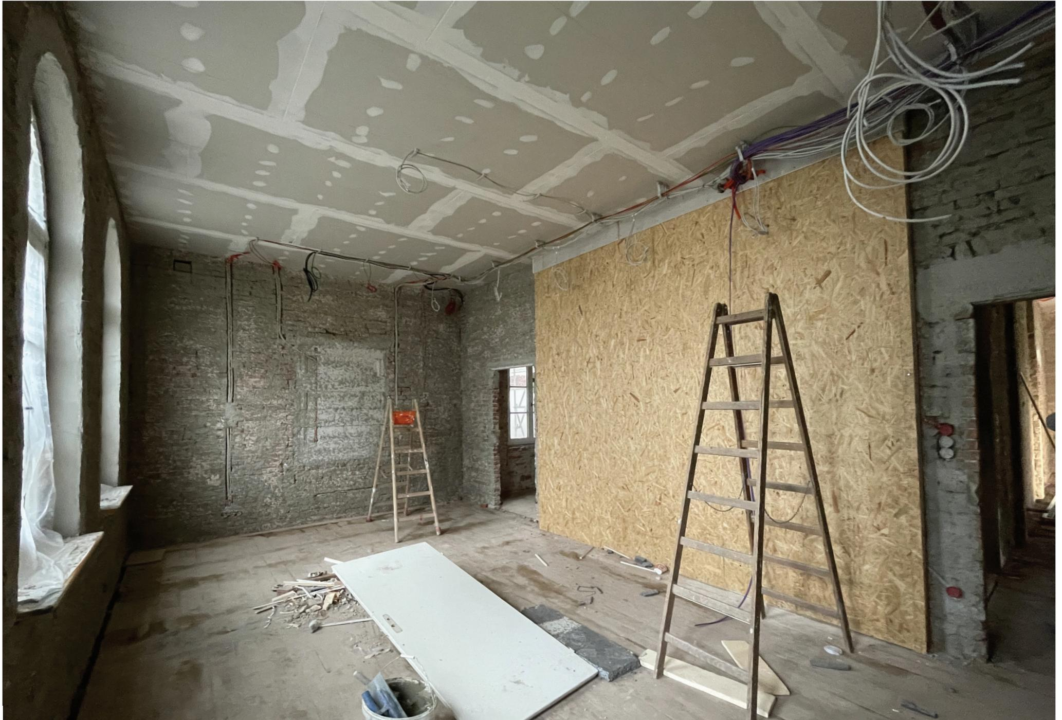
Altbau-Neu Obergeschoss N 1.21 | Exemplarisch für die notwendigen statischen und brandschutztechnischen Ertüchtigungen der Wände und Decken
