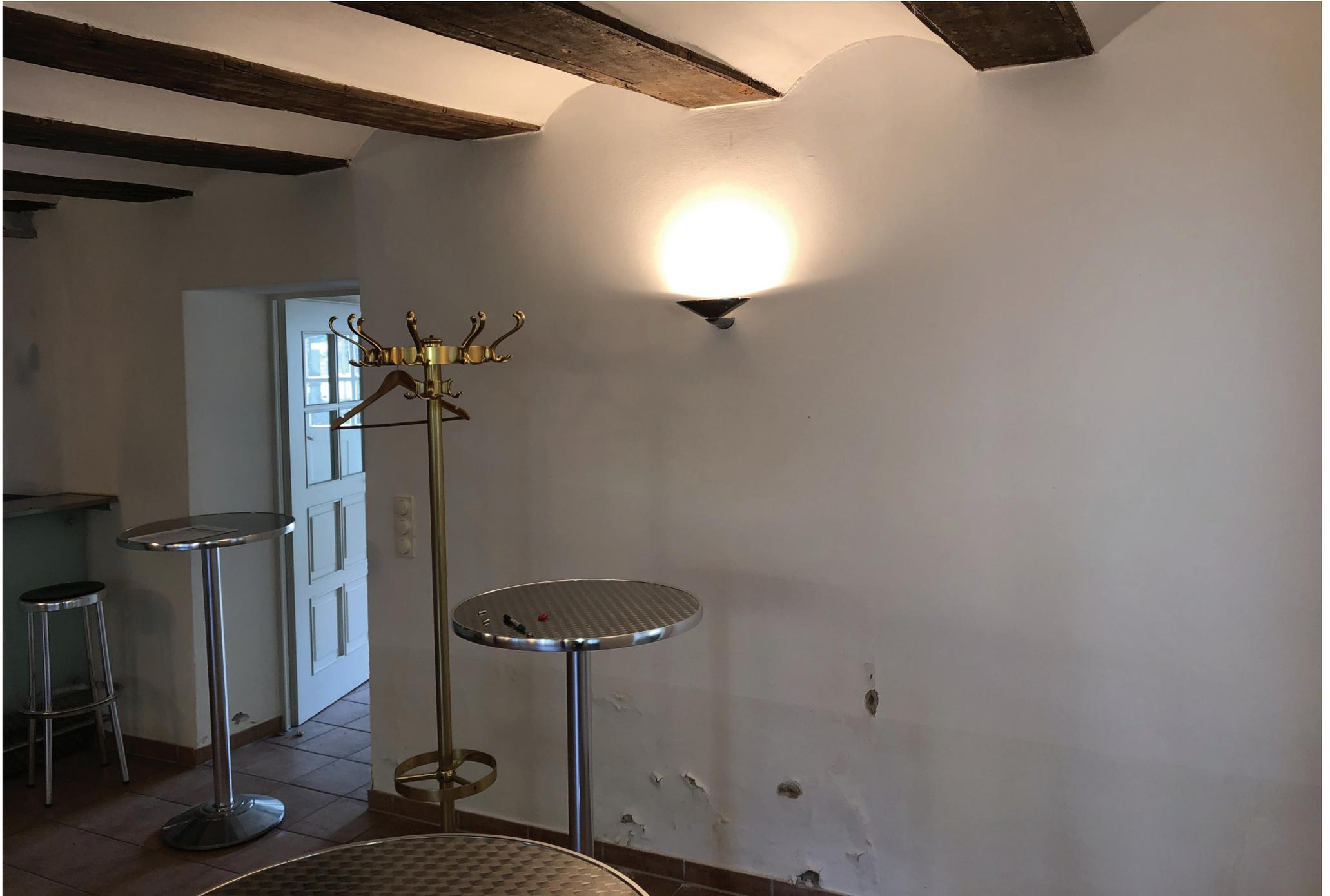
Altbau-Alt Erdgeschoss Gasträume I vorgefundener Bestand mit vereinzelt Feuchteschäden im Sockelbereich, Stand: Dezember 2019
