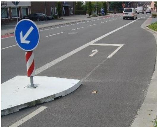
Abb. 21: Radfahrstreifen mit Aufstellbereich für linksabbiegende Radfahrer.
