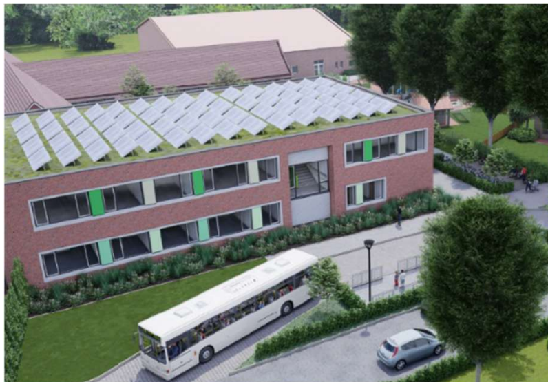
Gründach + PV Anlage mit Batteriespeicher
