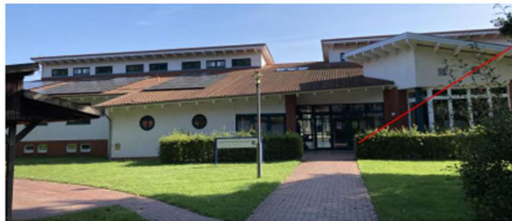
Eingang Brüsseler Straße
