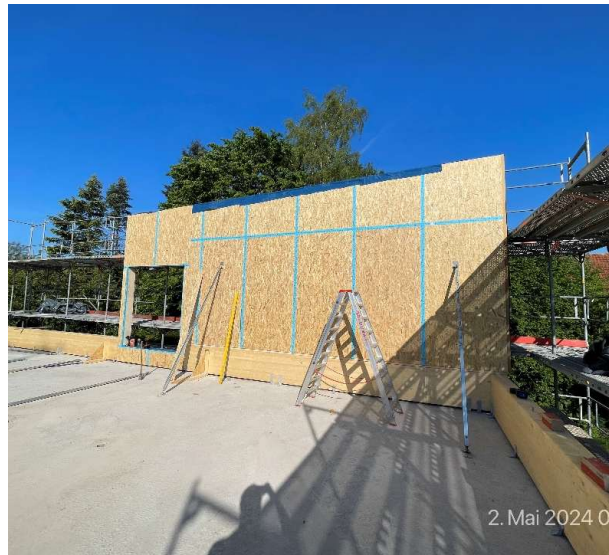
02.05.2024 Aufstellen der Wände
