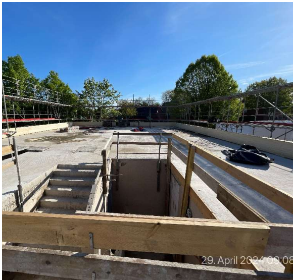
29.04.2024 Vorrichten der Schwellen
