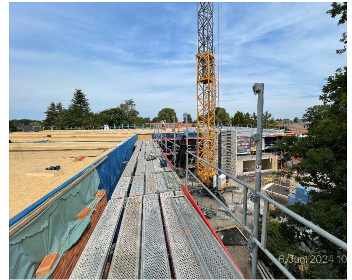
06.06.2024 Dach ist Fertig/ Beginn Dachdeckung
