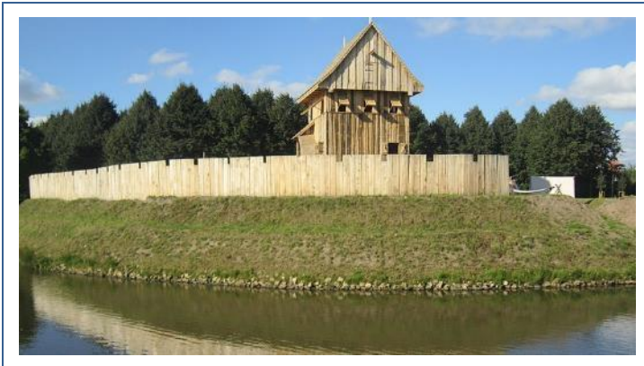
Abb. 14 Zitadellenpark – Nachbau Wehrturm 29
