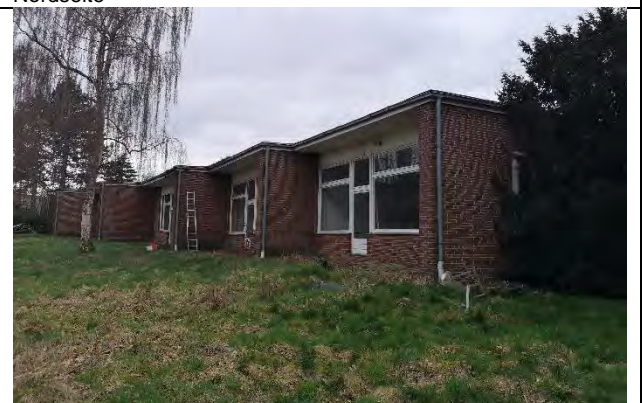
12 Südseite des Gebäudes mit den versetzt angeordneten Nischen
