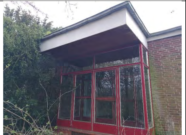
4 Nebeneingang im Osten des Gebäudes
