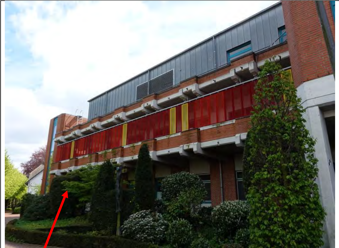
B7 Quartier 3 am Tag von der westlicher Seite aus betrachtet, der Pfeil markiert den Bereich mit den angeflogenen Stellen
