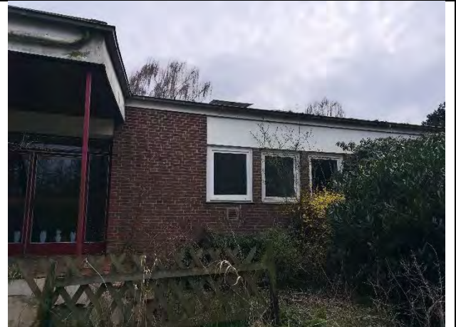
6 Nordseite des Gebäudes mit Nebeneingang im östlichen Teil
