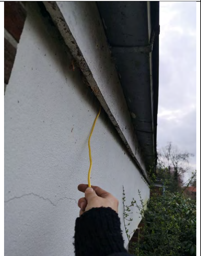
10 Spalt zwischen der Traufe und der Wand beispielhaft auf der Nordseite
