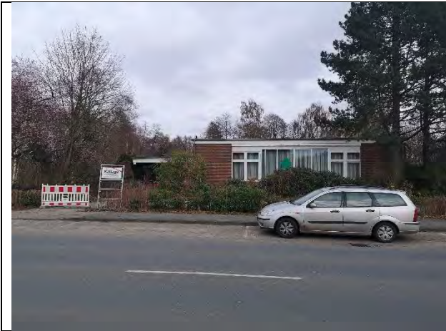
1 Blick auf das Gebäude von Westen und der Windallee aus, links im Bild der Haupteingang
