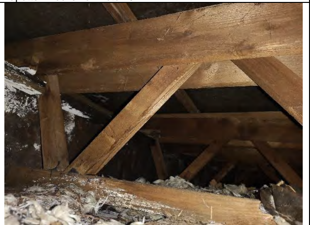
28 Blick in den Dachstuhl aus Blickrichtung der Lücke in der kaputten Decke von Foto 25
