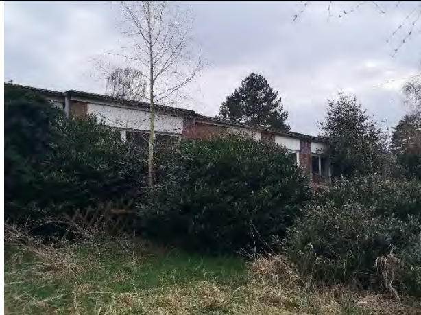
5 Nordseite des Gebäudes mit Blick nach Südwesten
