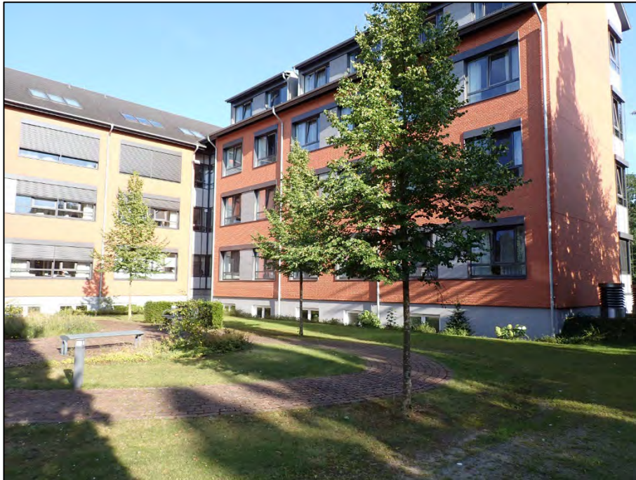
Abbildung 3: Grünanlagen (ER, GR) innerhalb des Klinikbereichs.
