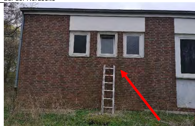
11 offenes Fenster auf der östlichen Nordseite
