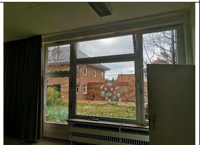
20 geöffnetes Fenster in der Nische von innen betrachtet
