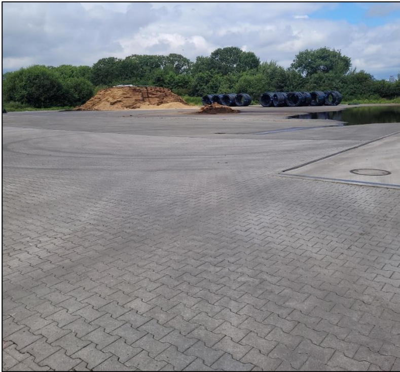
Abbildung 23: Befestigte Flächen des landwirtschaftlichen Betriebs, zum Teil asphaltiert (OFa) und zum Teil gepflastert (OFv).
