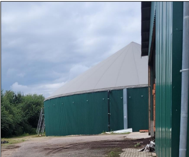
Abbildung 24: Biogasanlage (OKG) im südlichen Geltungsbereich.
