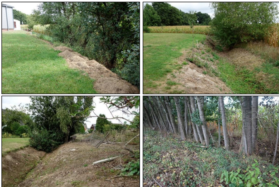
Abbildung 1: Beispiele für Abschnitte an den Gräben östlich der Straße Mühlendamm: Die dort im Kataster verzeichneten Wallhecken sind nicht mehr vorhanden.
